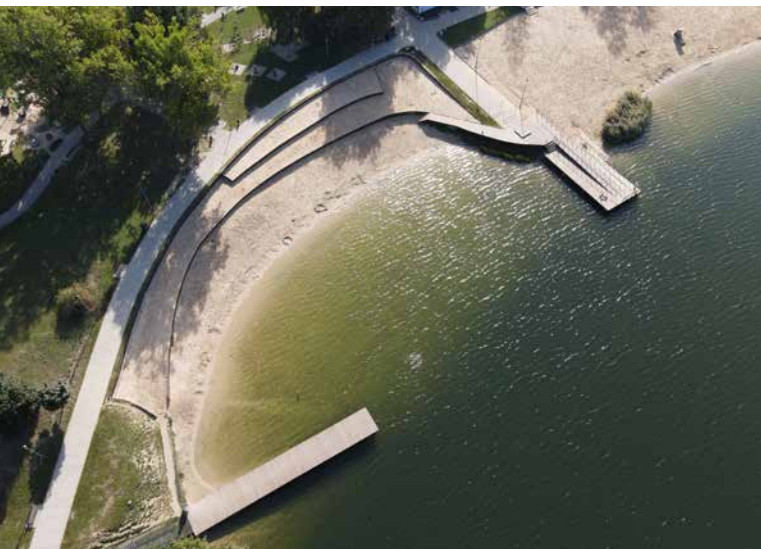
BO 2016: Zagospodarowanie Zalewu Bagry; fot. Rafał Zawiślak
