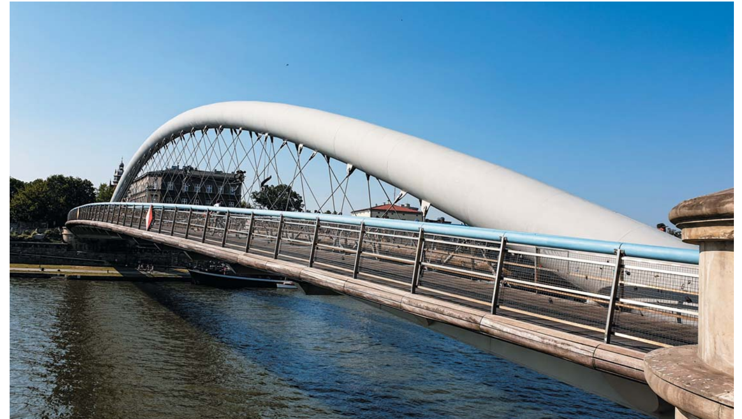
Kładka Ojca Bernatka
